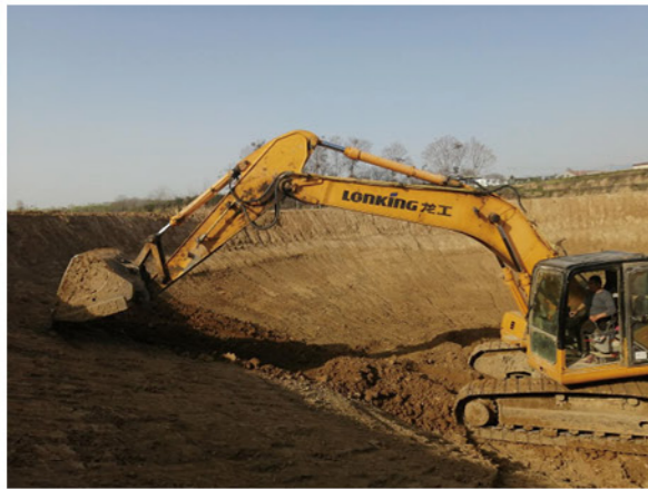
图3 漏斗形池塘施工图
